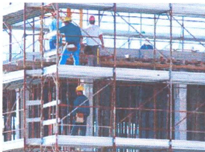
Operai al lavoro in un cantiere edile
